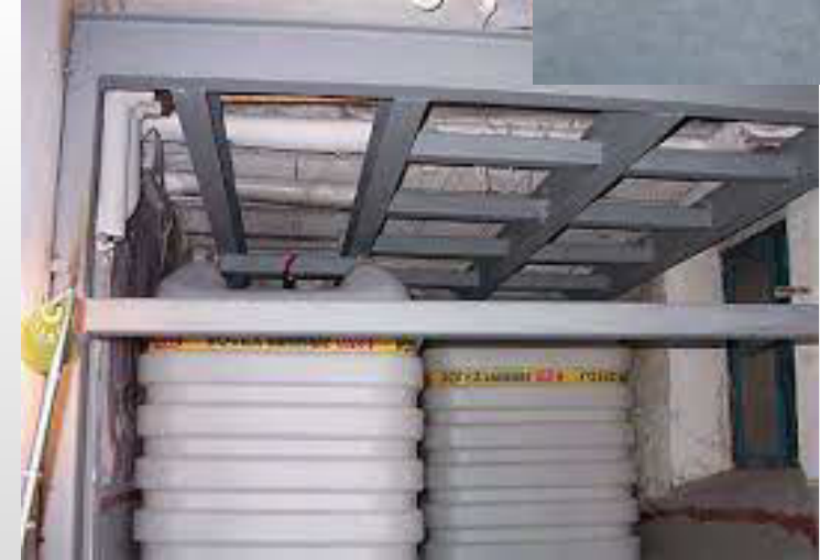
Variante 2 Tankanlage durch Verankerung sichern
